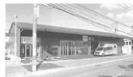
ビルディングの改修
