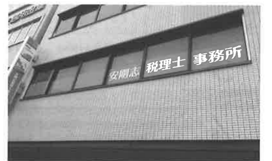
事務所が入居するRビル
